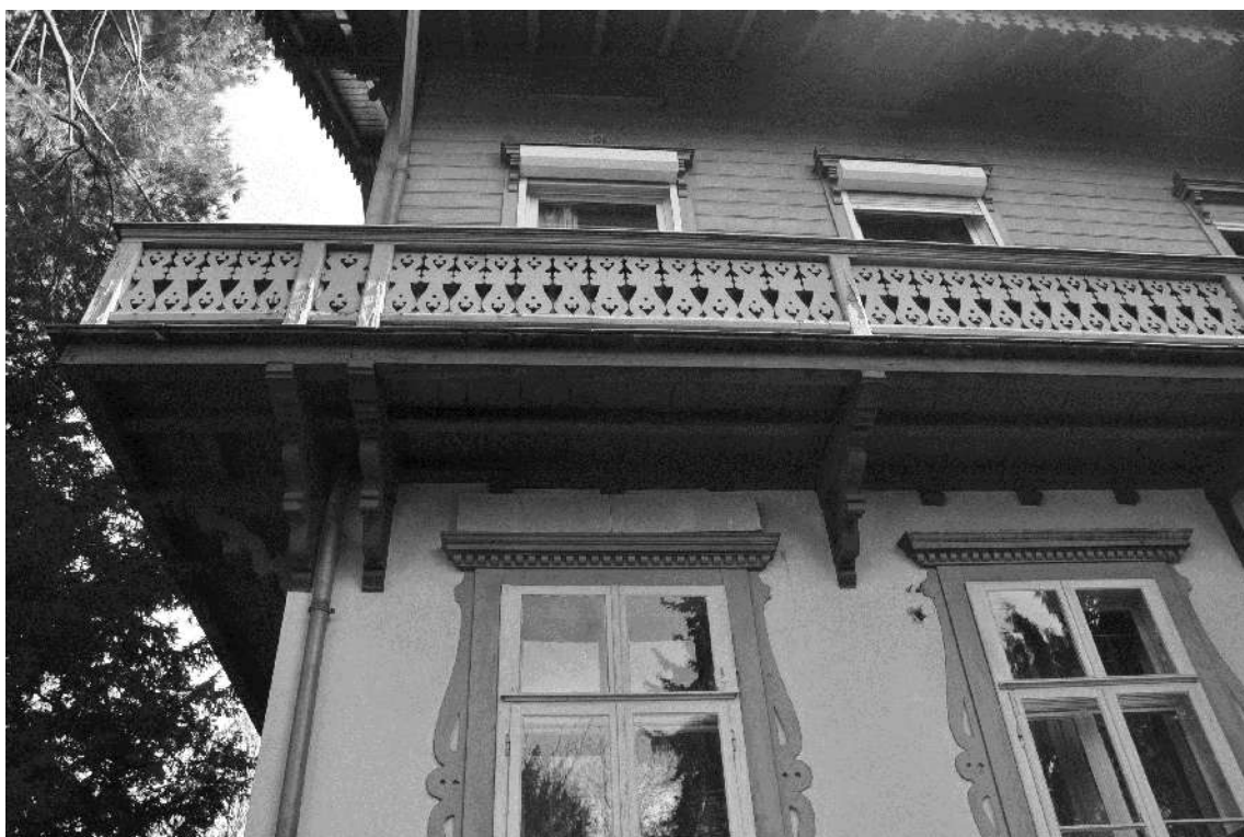
Balkongeländer mit Laubsägearbeit, Bretter in Form von Balustern ausgeschnitten. Den Balkon tragen Konsolen aus Holz.
